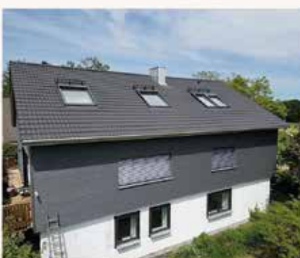
energetische Sanierungen für Dach und Wand, Fassadenverkleidungen
